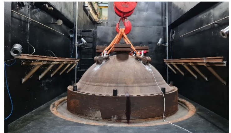
Rimozione testa Reattore Nucleare
