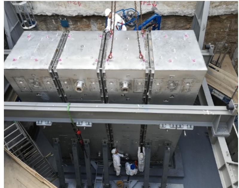
Impianto ITREC di Trisaia - Fossa 7.1. Posizionamento dei semi-contenitori per la rimozione del monolite interrato.
