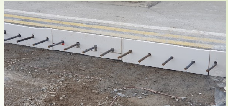
GIUNTO TRASVERSALE DI CONTRAZIONE TIPO "C"
