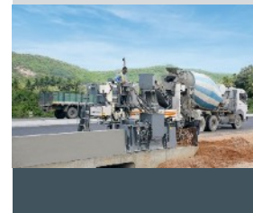
Barriera di protezione in cls con armatura
